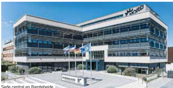
Sede central en Bargteheide
